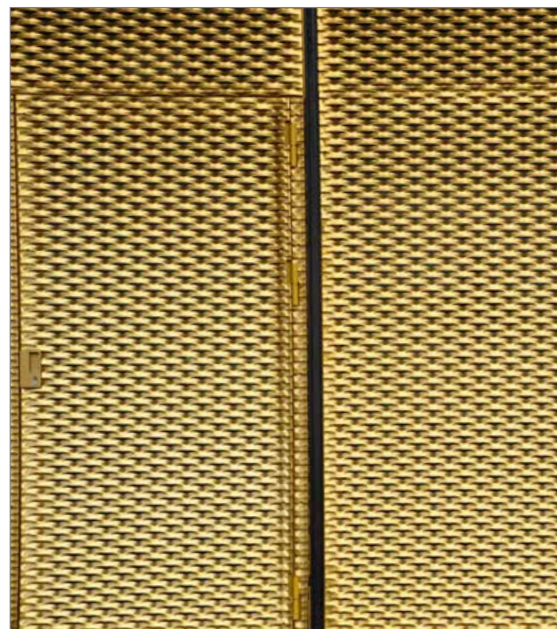
Feuerwehr Sand in Taufers, Falttore mit Isolierverglasung und außen angebrachter Streckmetallverkleidung Fire fighting station in South Tyrol, Bi-Folding Doors with tempered glass cladding and stretched metall facade
