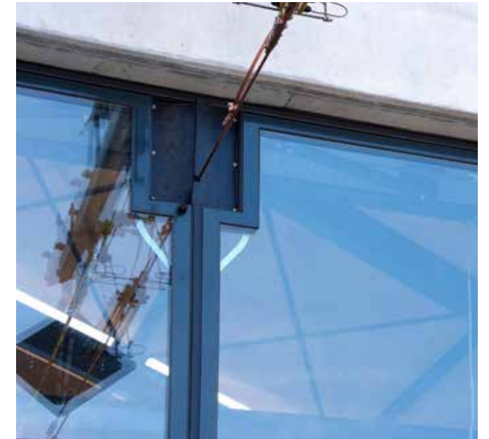
Falttöre für die Bahn mit Fahrdrahtausschnitt Folding doors for trains including overhead wire cutout
