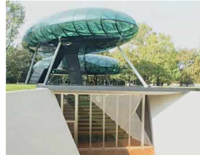
Drehschiebetor aus thermisch getrennten Edelstahlprofilen, Höhe 6 m, VSG Verglasung. Turning-sliding door, broken profiles out of stainless steel, 6 m height, laminated glass.
