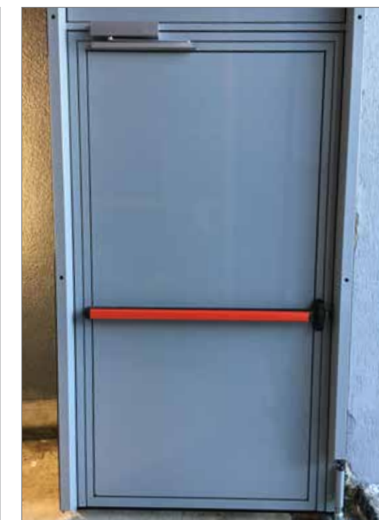
Integrierte schwellenlose Schlupftür mit Panikbeschlag Integrated personnel door without threshold
