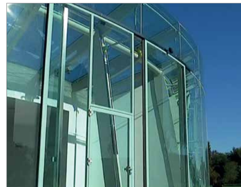
Automatisches halbrundes Glasschiebetor mit einer Gehtür Automatic glazed curved sliding door with a personnel door
