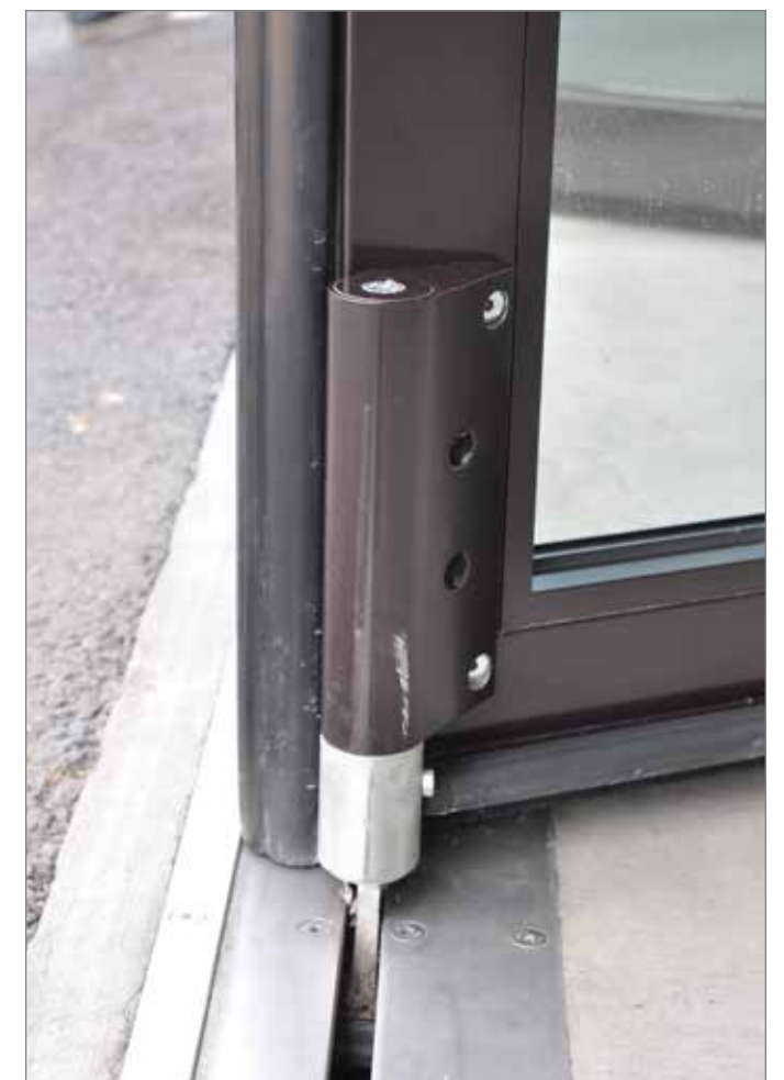
Auf Wunsch Edelstalführungsschiene und Rollen On demand guiding rails and rollers out of stainless steel
