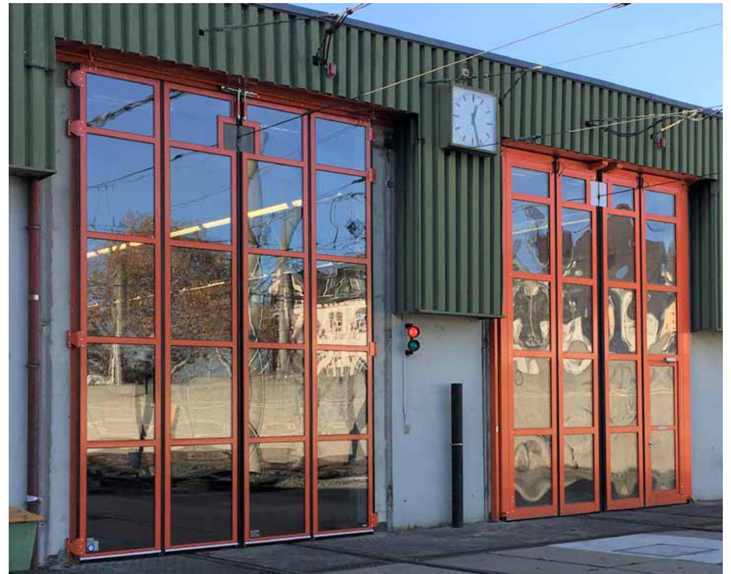
Falttöre für die Bahn mit Fahrdrahtausschnitt Folding doors for trains including overhead wire cutout
