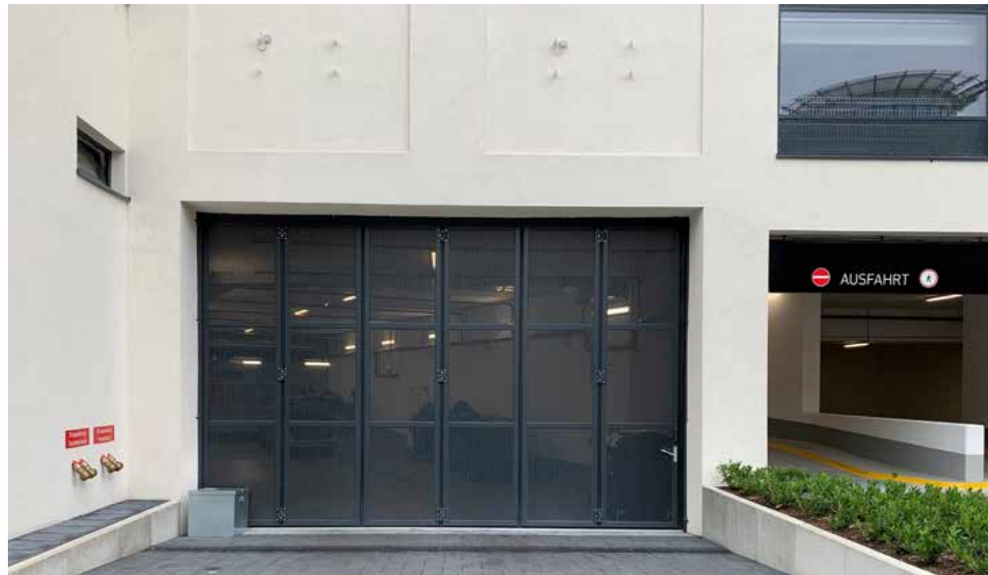
Sonderanfertigung: Schiebefalttor mit Lochblech als Füllung Custom-made: Sliding folding door with perforated plate as filling
