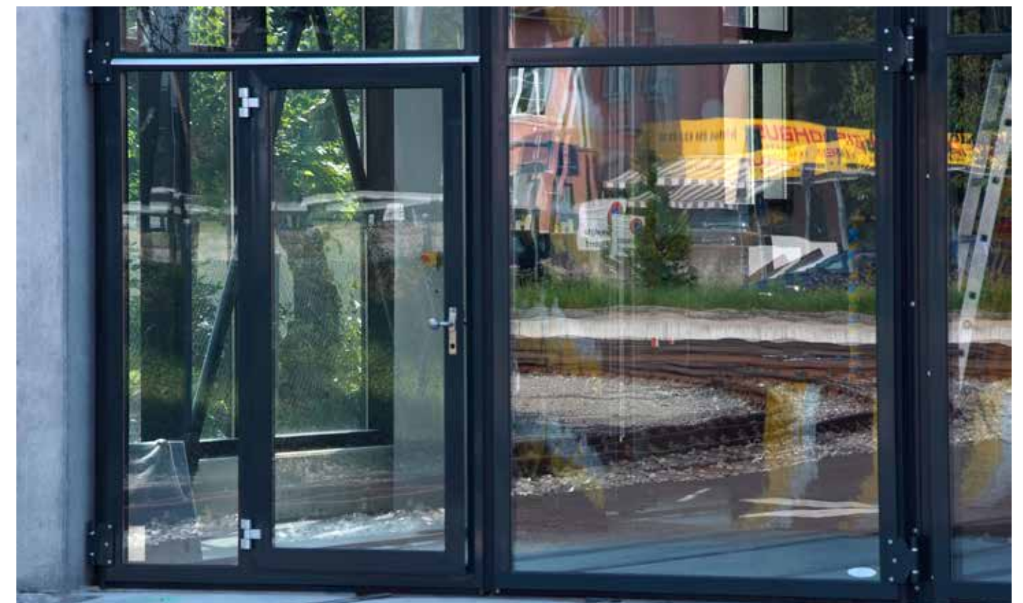
Festteile und Türen in der Toro-optik Fix elements and man door in the same optic
